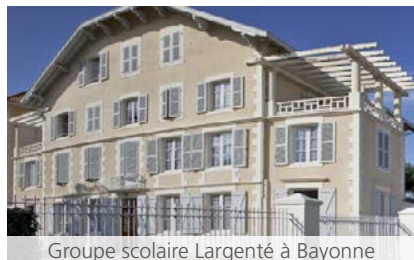
Groupe scolaire Largenté à Bayonne
